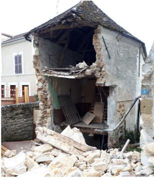
Pour rappel, le 18 janvier 2018, après plusieurs jours de fortes pluies, un glissement de terrain a provoqué l'effondrement d'une partie du bâtiment principal, laissant un trou de trois mètres et menaçant le pavillon au-dessus. Quelques semaines plus tard, pour des raisons de sécurité, une partie du bâtiment a dû être entièrement déconstruit.
