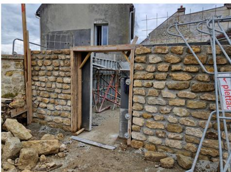
Coté atelier/appartements, des fondations ont été réalisées, la dalle béton coulée et les murs de l'atelier construits. L'élévation des murs des appartements est la prochaine étape.
